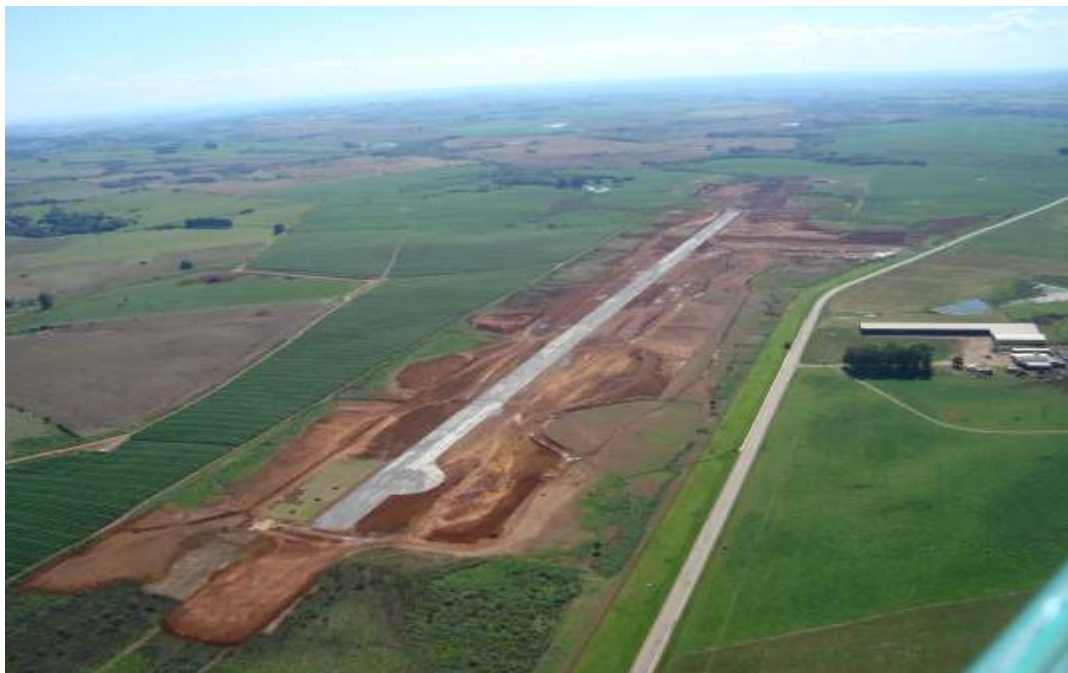
Asfaltamento da pista do Aeroporto de Cargas de Vacaria
